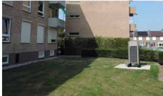
Appartement complexen: Alutherm cv-ketels met warmtepomp deel in de stookruimte. 32kW buitendeel warmtepomp (VRF) achter gebouw.
