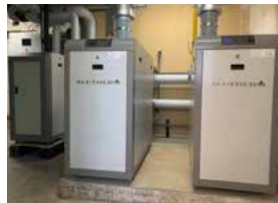
Woonzorg/centra's: 2 Alutherm cv-ketels met losse hybride Connect2 binnendeel warmtepomp met slimme besturing, platenwisselaar per 32kW buitendeel en 2x 32kW warmtepomp buitendelen (VRF).
