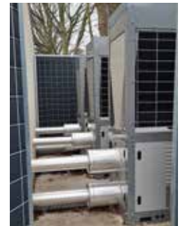
Ziekenhuis: 3 Alutherm A260 cv-ketels, Alutherm Hybride COconnect2 schakelkast en 3x 70kW warmtepomp buitendelen (monobloc).
