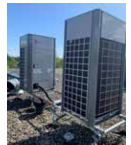
Woonzorg/centra's: 2 Alutherm cv-ketels met losse hybride Connect2 binnendeel warmtepomp met slimme besturing, platenwisselaar per 32kW buitendeel en 2x 32kW warmtepomp buitendelen (VRF).
