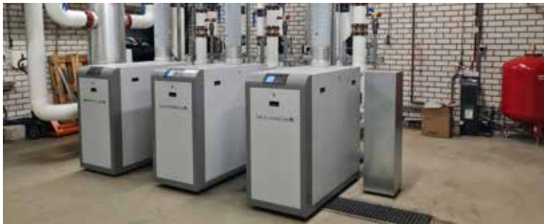
Ziekenhuis: 3 Alutherm A260 cv-ketels, Alutherm Hybride COconnect2 schakelkast en 3x 70kW warmtepomp buitendelen (monobloc).
