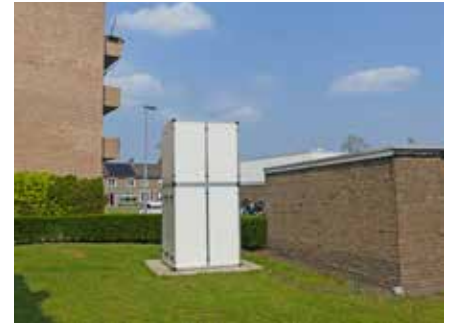
Geluidsscherm waarmee reductie van geluid ~ 15 dB(A) is gerealiseerd.
