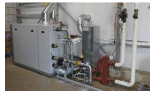
Tuincentra/kassen: 2 x 32kW warmtepomp buitendelen met in de stookruimte een Alutherm cv ketel met geïntegreerd warmtepomp binnendeel en slimme besturing.
