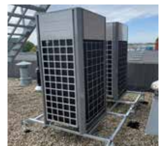
Kantoor & bedrijfspanden: 2 Alutherm cv ketels, Hybride Connect2 binnendeel warmtepomp, 2 x 32kW VRF buitendeel warmtepomp dakopstelling.
