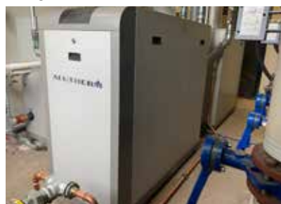
Kantoor & bedrijfspanden: 2 Alutherm cv ketels, Hybride Connect2 binnendeel warmtepomp, 2 x 32kW VRF buitendeel warmtepomp dakopstelling.
