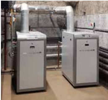
Appartement complexen: Alutherm cv-ketels met warmtepomp deel in de stookruimte. 32kW buitendeel warmtepomp (VRF) achter gebouw.
