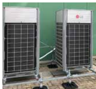
Tuincentra/kassen: 2 x 32kW warmtepomp buitendelen met in de stookruimte een Alutherm cv ketel met geïntegreerd warmtepomp binnendeel en slimme besturing.
