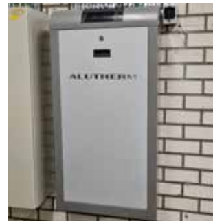
Ziekenhuis: 3 Alutherm A260 cv-ketels, Alutherm Hybride COconnect2 schakelkast en 3x 70kW warmtepomp buitendelen (monobloc).
